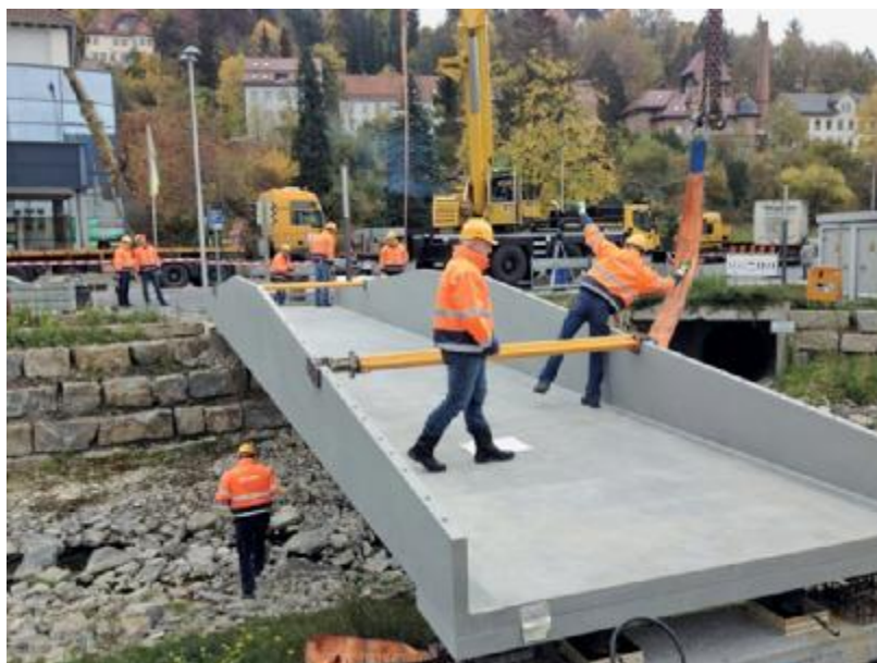
Рисунок 3 - Пешеходный мост в Германии, город Альбштадт-Эбинген (Albstadt-Ebingen), построенный в 2016 году из бетона на основе углеродного волокна (Carbonbeton)
